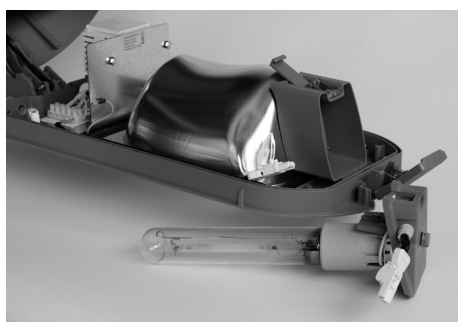
7 Remplacement de la lampe
