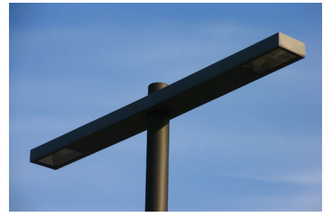
2 luminaires de hauteur identique
